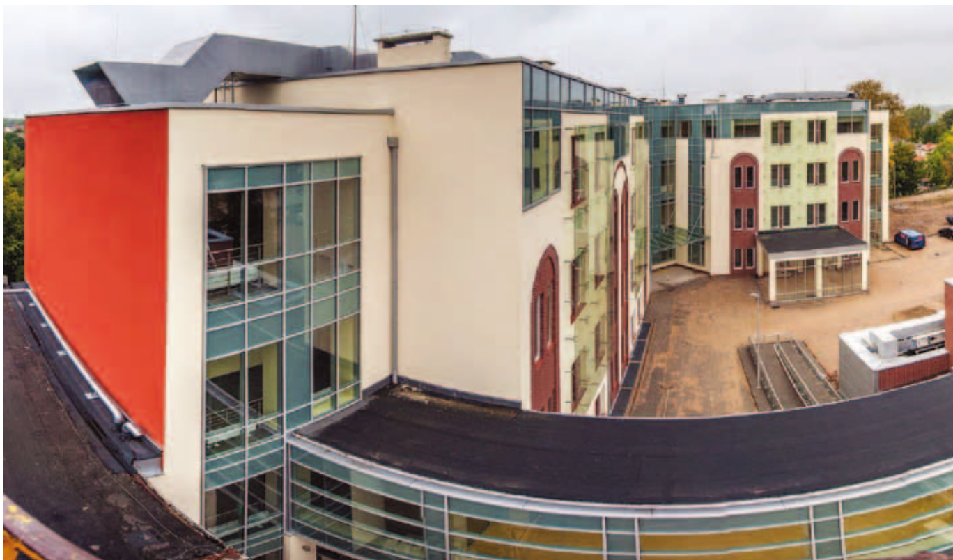
Nowy budynek szpitala
